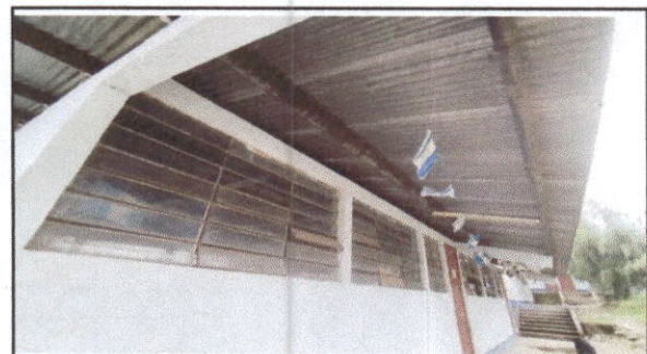
Foto 4: Sustitución de canal de metal
