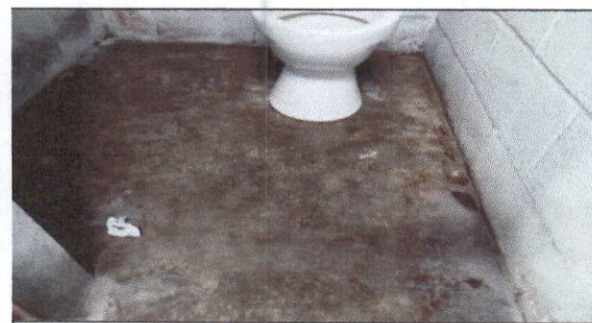
Foto 6: Reparación de piso cerámico
