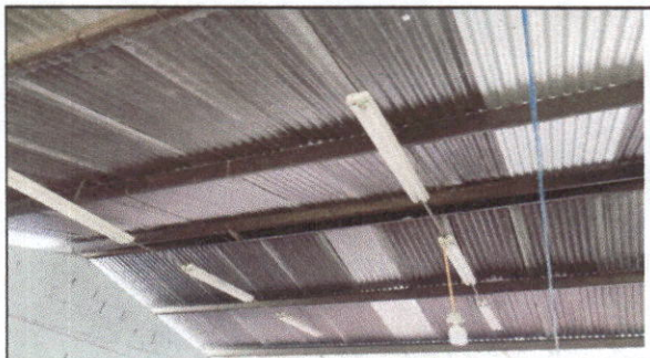
Foto 3: Mantenimiento a estructura de soporte de metal
